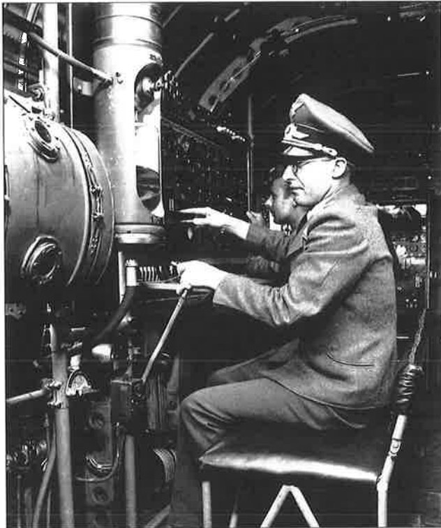
Ju 52 ausgerüstet als „Fliegender Prüfstand“
