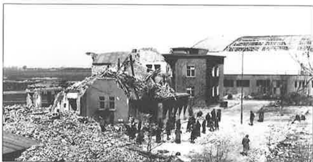
Zerstörtes Verwaltungsgebäude von E3
